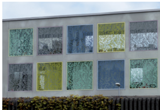
Dobře viditelné vzory listů na tabulích skla ve spojovací chodbě mezi bytovými domy
