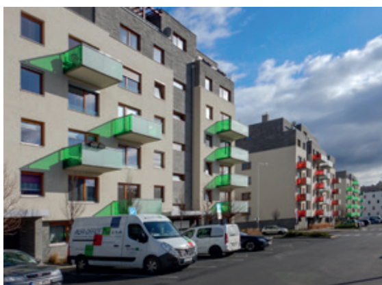
Barevná skla zástavbu ožíví a zároveň jsou pro ptáky bezpečná.
