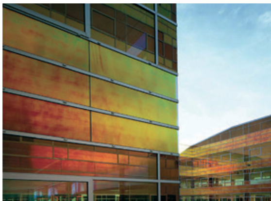
Díky výrazně zbarvenému, nízkoodrazivému sklu a neprůhledným rohům je tato budova pro ptáky bezpečná
