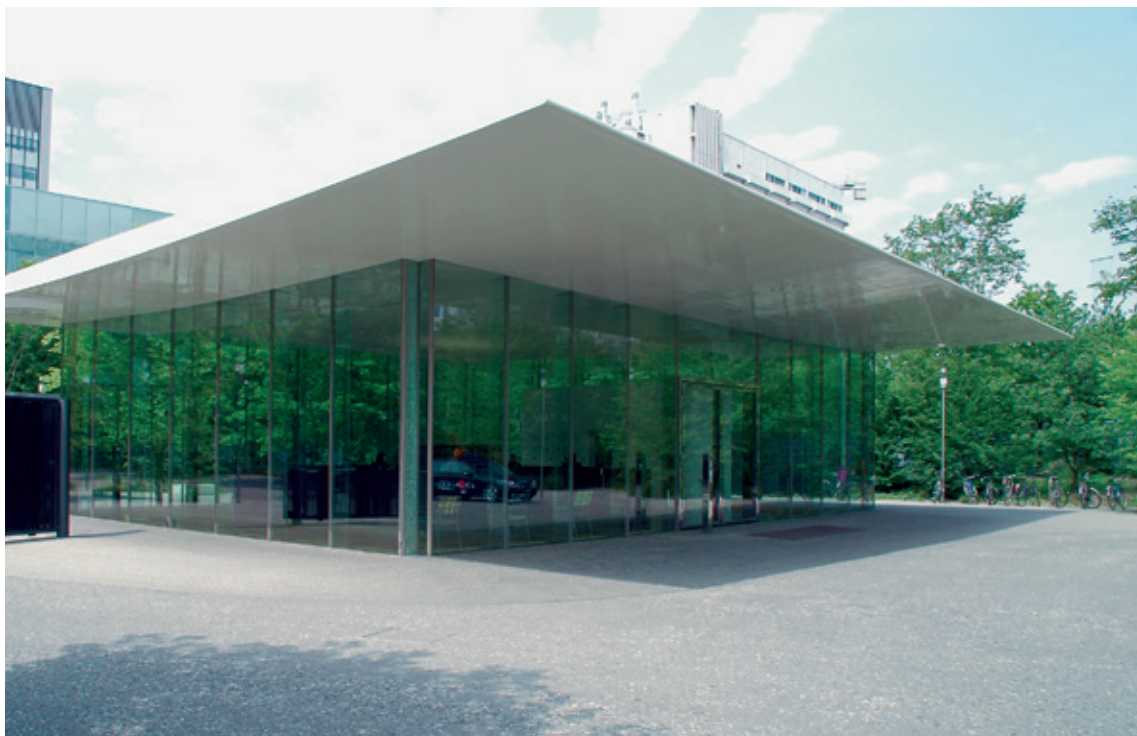
Budova recepcce velké průmyslové společnosti. Toto optické spojení interiéru a exteriéru je pro ptáky extrémně nebezpečné. Stejně nebezpečné jsou budovy u vodních nebo zelených ploch, kde odrazivé fasády splývají s okolím.
