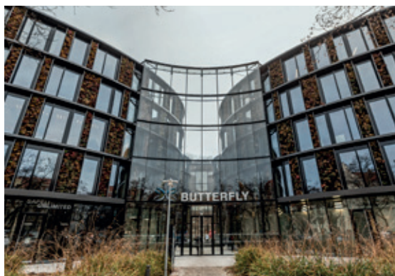
Větrná a akustická bariéra mezi budovami
