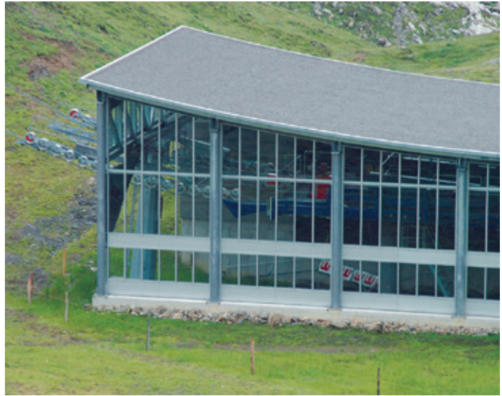
Údolní stanice horské lanovky, prosklená ze tří stran: ptáci prchající před padajícím sněhem vletí do budovy a narážejí do skel – většinou zevnitř
