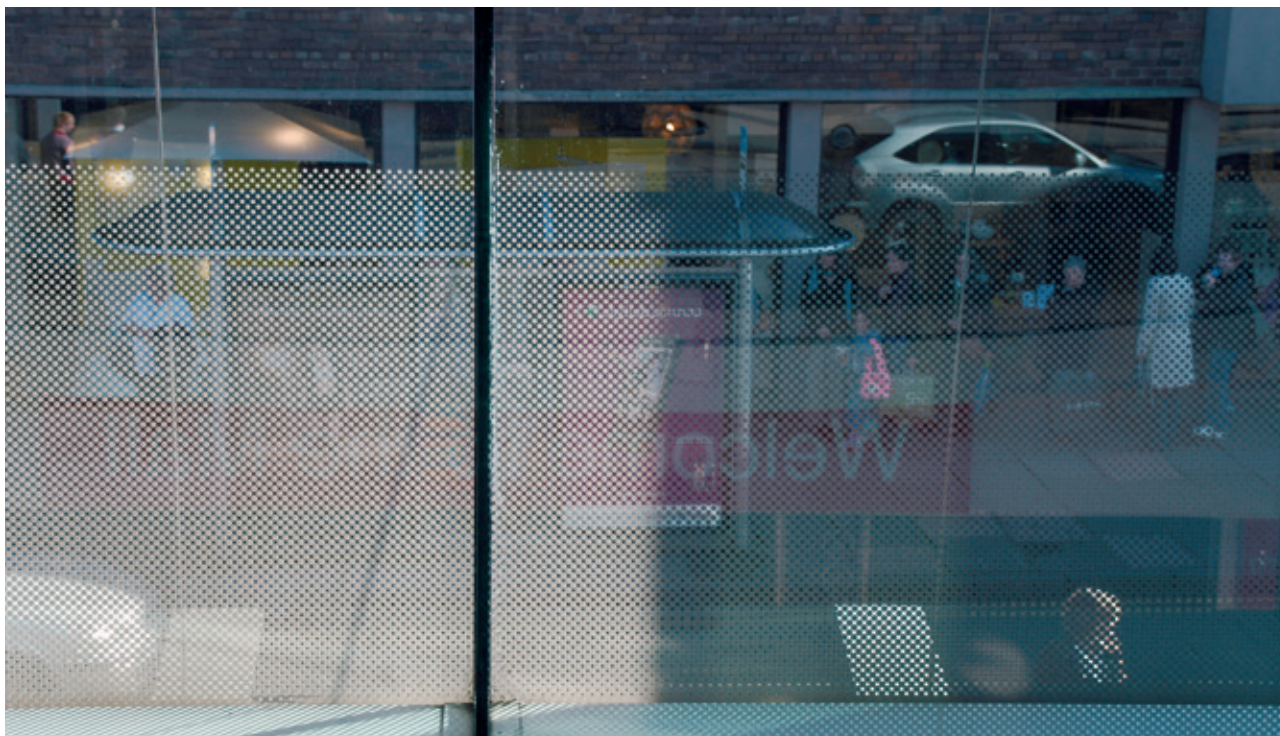
V závislosti na světle mají vzory na skle různé účinky. Tato výloha je pokryta velmi hustým tečkovaným vzorem. Zatímco pravá strana ve stínu je poloprůhledná a je skrz ni vidět, levá strana je mnohem více zastíněná. Pro prevenci kolizí nemusí být vzor takto hustý.
