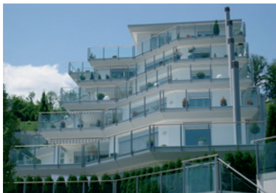
Bytový dům s řadou prosklených balkonových zábradlí a zábran
