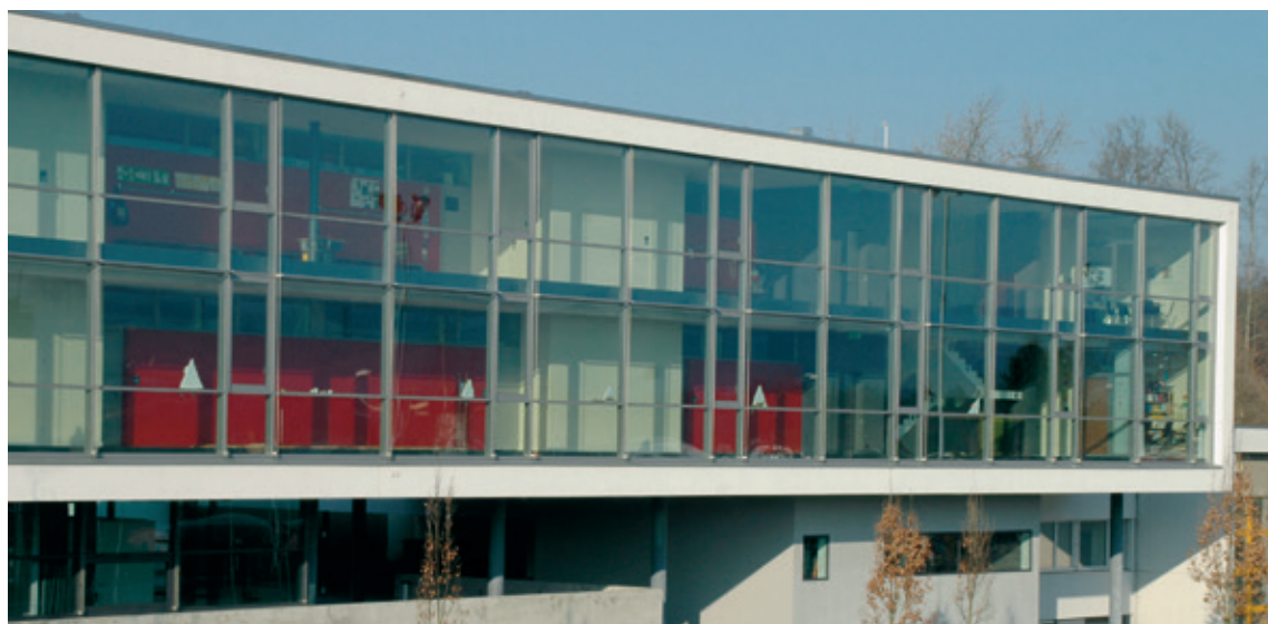
Díky sklu s nízkou odrazivostí lze vidět do interiéru této školní budovy. Ptáci by tak do této pro ně neatraktivní budovy měli létat jen výjimečně. I když nové stromy časem vyrostou, budou se ve skle odrážet jen minimálně.
