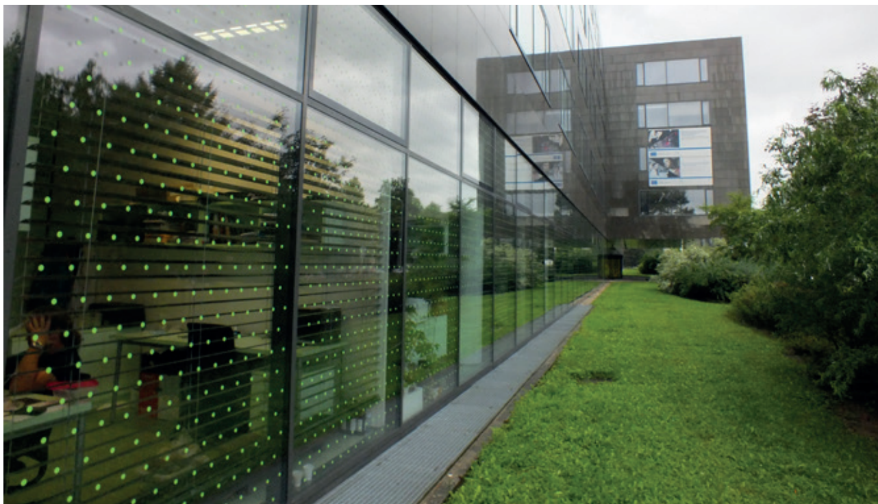
Kombinace vysoce reflexních skel a zrcadlící fasády s vytvořením optického klamu pokračování budovy je pro ptáky více než nešťastná. Komplexní prevence kolizí je v takovém případě nereálná, zabezpečení skel řeší problém jen částečně.
