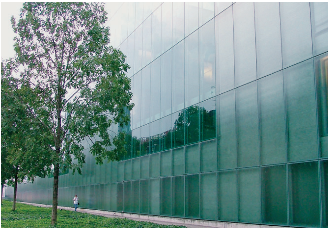
Ukázka špatné výsadby: stromy stojí přímo před částmi budovy s vysoko odrazivým sklem. Během jediného podzimu zde uhynuly stovky sýkor uhelníčků. Tato překážka v krajině, kterou prochází migrační trasa, blokuje let ptáků. Odrazy stromů vytvářejí iluzi volného průletu.
