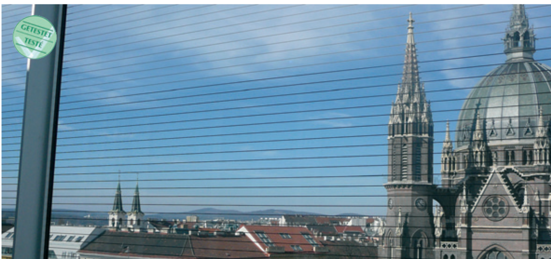
Vodorovné černé čáry tloušťky 2 mm s roztečí 28 mm vykazovaly v průletovém tunelu navzdory všem očekáváním velmi dobré výsledky. Tam, kde je důležité zajistit co nejlepší viditelnost, např. před světlým pozadím, jsou přijatelným řešením. Doporučovali bychom však tloušťku čar alespoň 3 mm.
