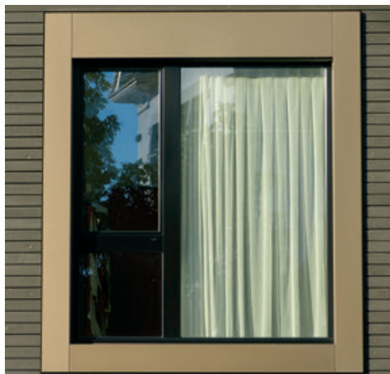
Světlé závěsy zavěšené blízko okna snižují odrazivost: rozdíl je více než zjevný
