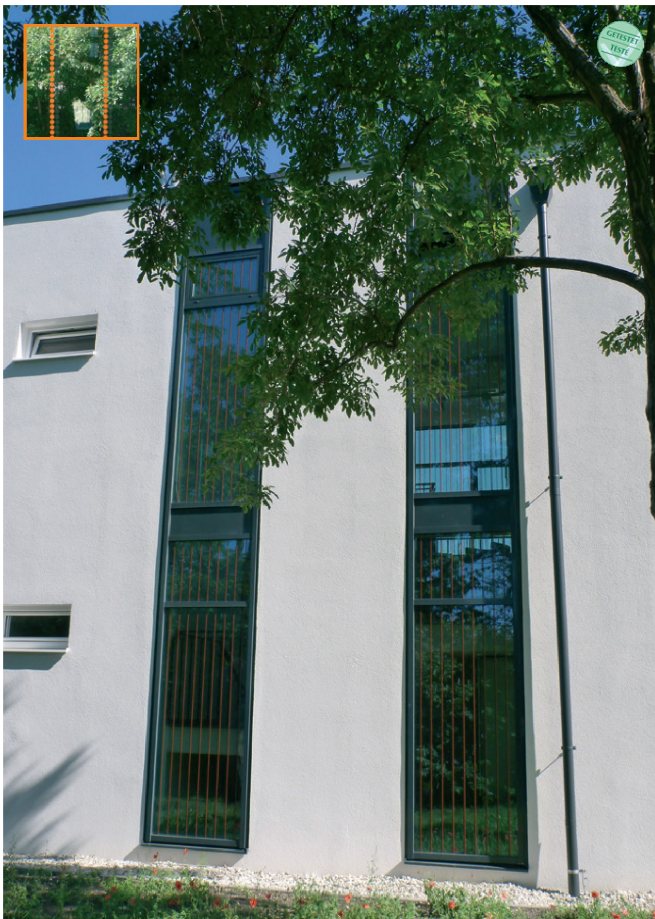
Jeden ze vzorů, který se v průletovém tunelu ukázal jako vysoce účinný, je nyní běžně k dostání; potisk tedy není třeba na sklo aplikovat až po dokončení stavby
