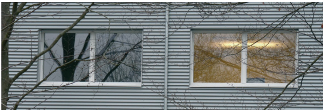
Odrazivost závisí na řadě faktorů, například na osvětlení vnitřního prostoru za oknem. Stejně sklo vytváří tím silnější odrazy, čím tmavší je pozadí za ním.
