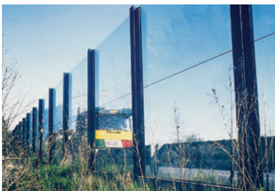
Průhledná protihluková stěna
