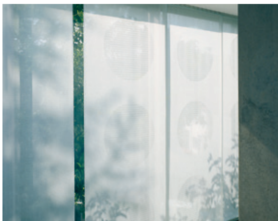
Průhledné ploché žaluzie jsou účinnější než závěsy, neboť jsou vždy zatažené. Fungují však pouze u skla s nízkým indexem odrazivosti.
