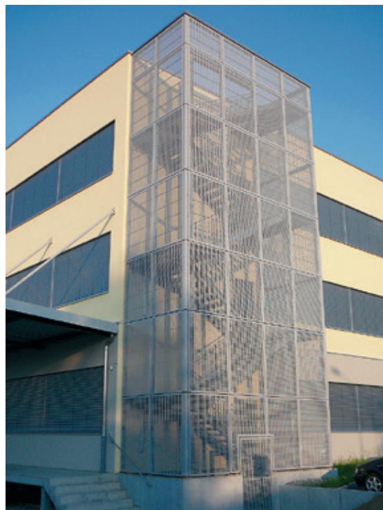
Drátěné pletivo propouští světlo, je ekonomické a zároveň chrání ptáky
