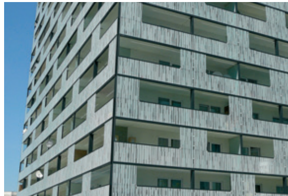
Tištěný vzor zaručuje soukromí uživatelům terasy a zároveň obohacuje 3D strukturu budovy
