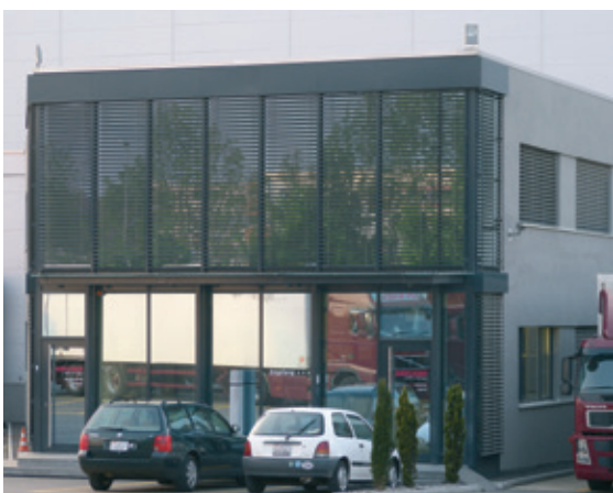
Protisluneční sklo v budově recepcy: žaluzie v horním patře výrazně snižují odrazivost skla
