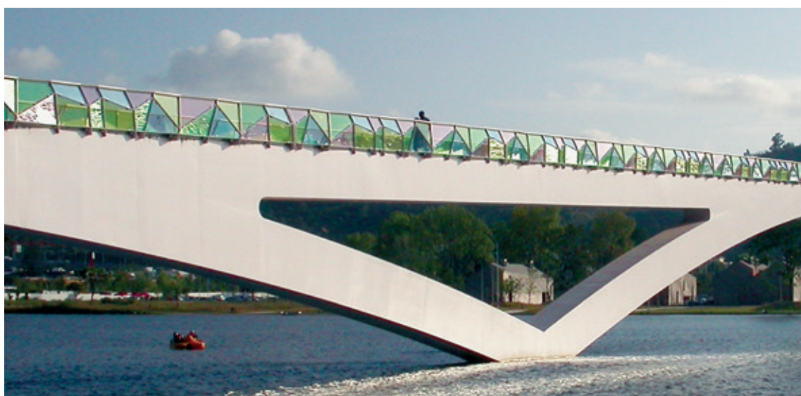
Tato lávka ve městě Coimbra v Portugalsku dává konstrukci barevný nádech
