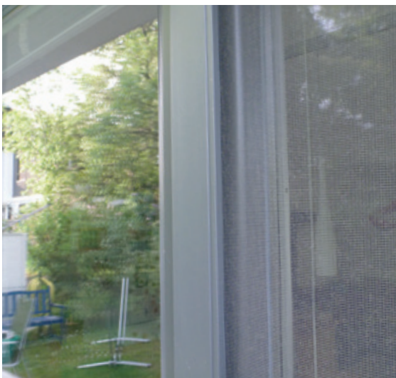
Instalace venkovní sítě proti hmyzu (okno vpravo) odrazivost výrazně snižuje
