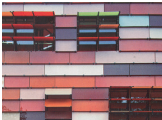
Protože zde použité skleněné tabule jsou poloprůhledné, mají malou plochu a nízkou odrazivost, mohou je ptáci snadno vidět
