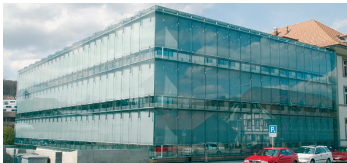
Integrovaný stínící systém v prosklené fasádě. Odrazivost není zcela odstraněna a v různých úhlech se zvyšuje. I přes to – a díky použitým lehké zbarveným materiálům – jsou odlesky na přijatelné úrovni.
