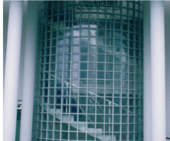
Skleněné tvárnice jsou řešením velmi bezpečným pro ptáky a z hlediska jejich ochrany je lze použít bez omezení
