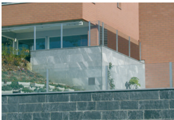
Prosklené balkonové stěny a protihlukové stěny
